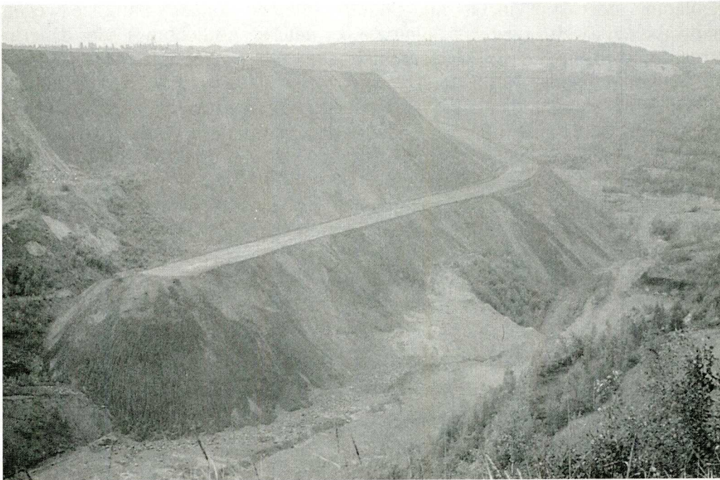
Bild: ehemaliger Tagebau Lichtenberg, Ronneburg (Thüringen), Juni 1992. Die in den Tagebau führende Rampe wurde aus Material der Gessenhalde angeschüttet.
