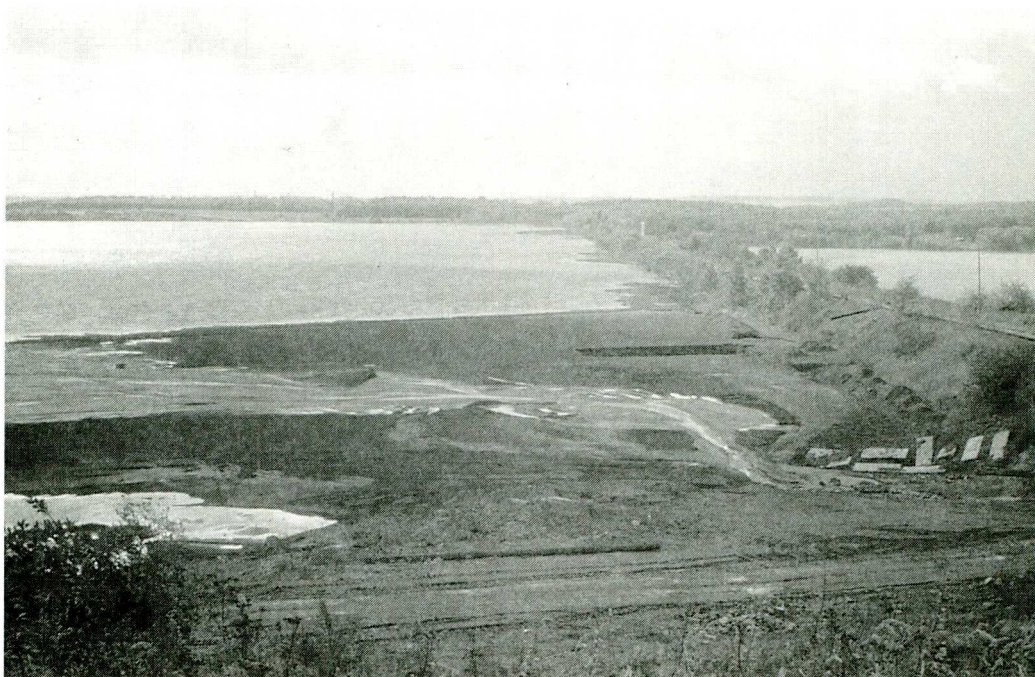
Bild: Die beiden Teilbecken der Schlammdeponie Culmitzsch bei Seelingstädt (Thüringen) vor der inzwischen erfolgten Abdeckung der freiliegenden Spülstrände, September 1990, Gesamtinhalt 90 \text{ Mio.t}
