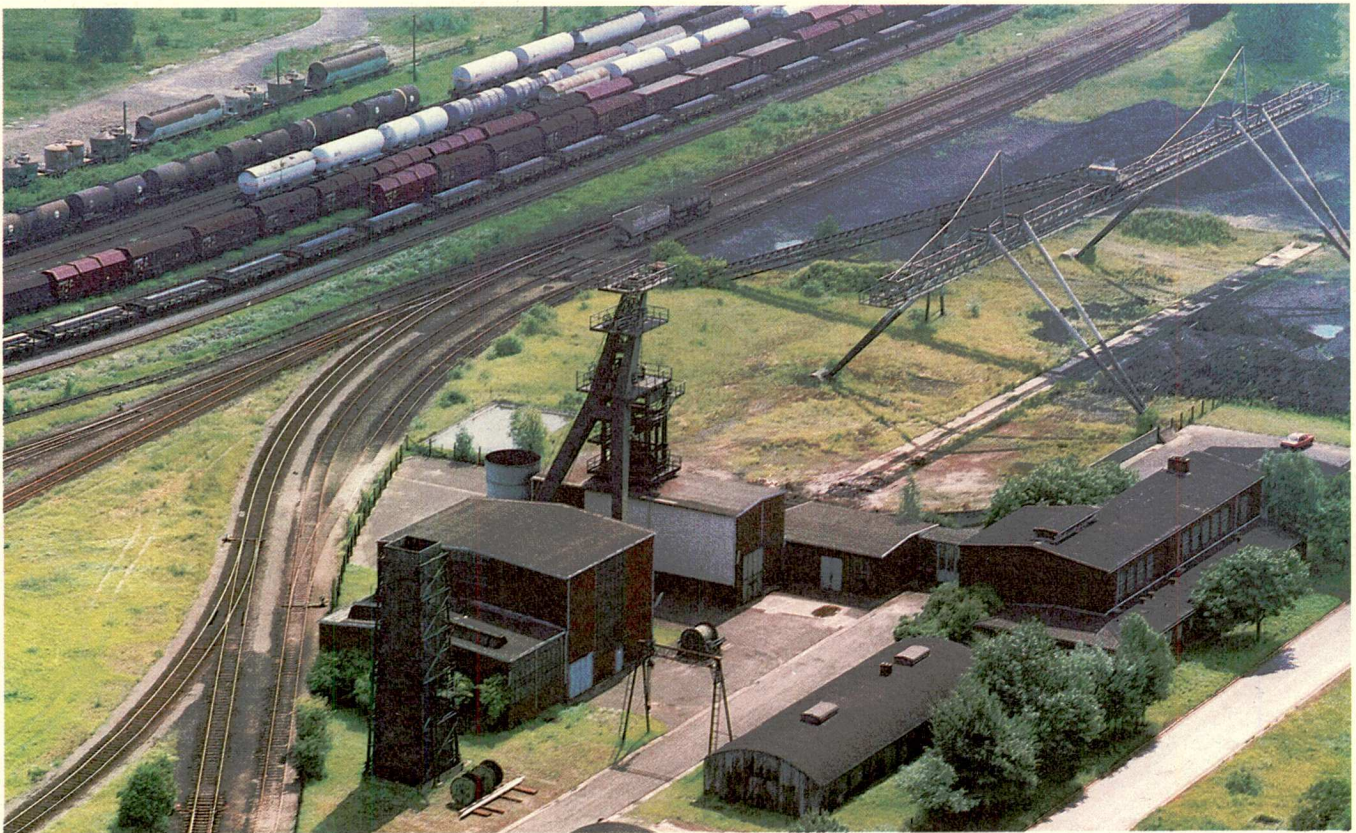
Ab ins Erz: Wo einst wertvolles Gestein im Förderkorb nach oben gelangte, soll zukünftig Atommüll in die Tiefe hinabgelassen werden. Foto: Physikalisch-Technische Bundesanstalt
