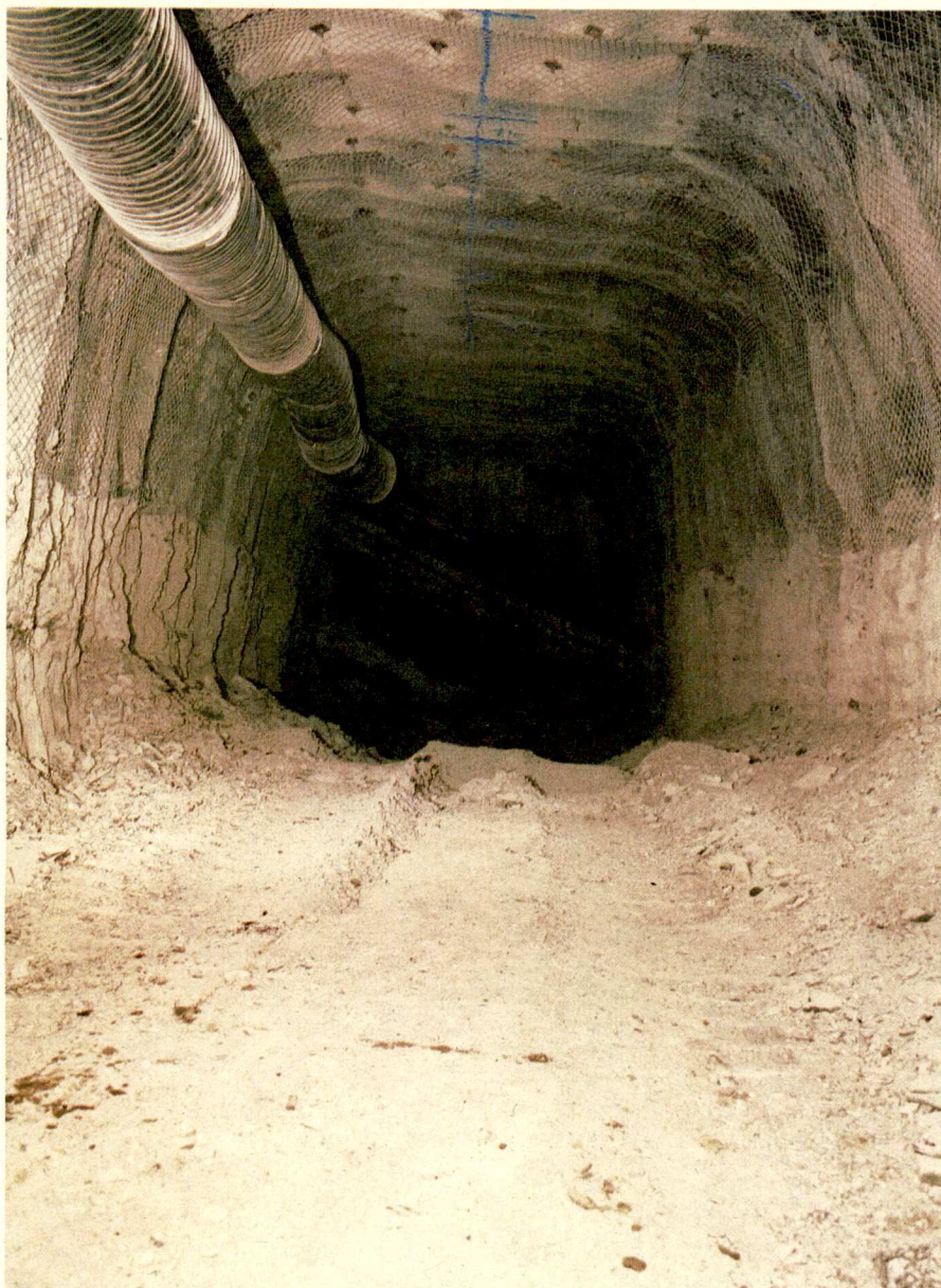
Schöne neue Unterwelt: 650 000 Kubikmeter Hohlraum sollen das steinerne Grab für strahlenden Abfall werden.
